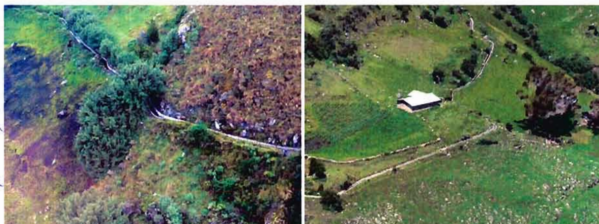
Fotografía 19. Tramos intermedios del canal Chailhuagón Yerbabuena.
